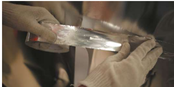
Рис. 3.2.б. Проклейка стыков пароизоляции
