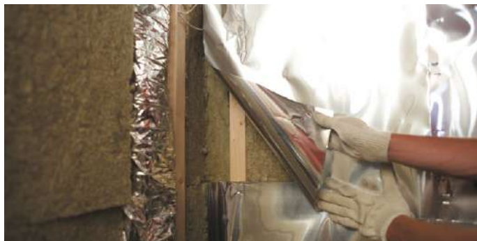
Рис. 3.2.а. Проклейка стыков пароизоляции
