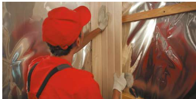
Рис. 4.1. Устройство внутренней обшивки
