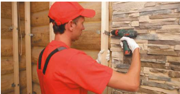
Рис. 1.1. Установка каркаса под теплоизоляцию
