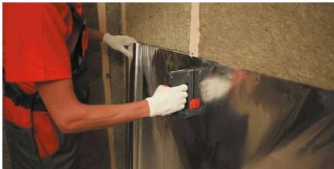
Рис. 3.1. Монтаж пароизоляции
