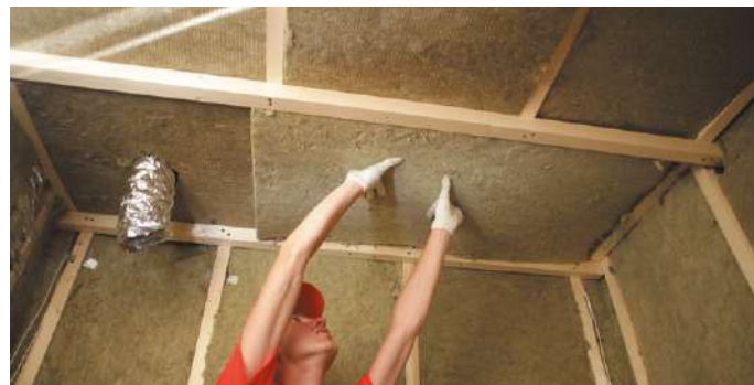
Рис. 2.1. Укладка плит теплоизоляции
